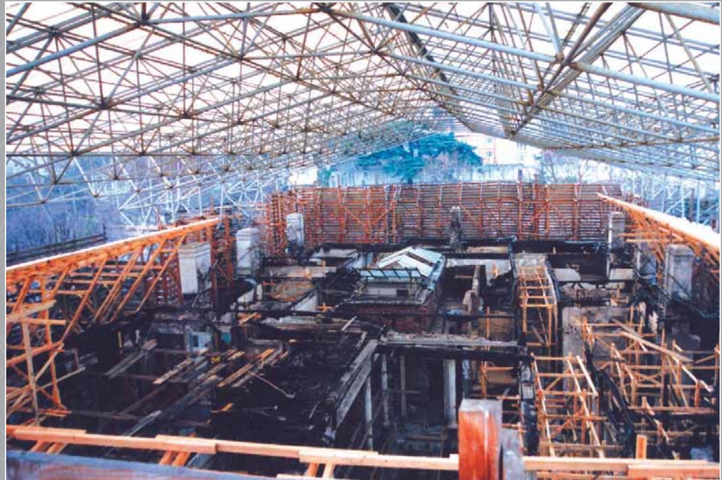
*Yangın sonrası çatısı, tavanları ve duvarları yok olmuş yapıının birinci kat ve zemin kattaki harabe görüntüsü*
