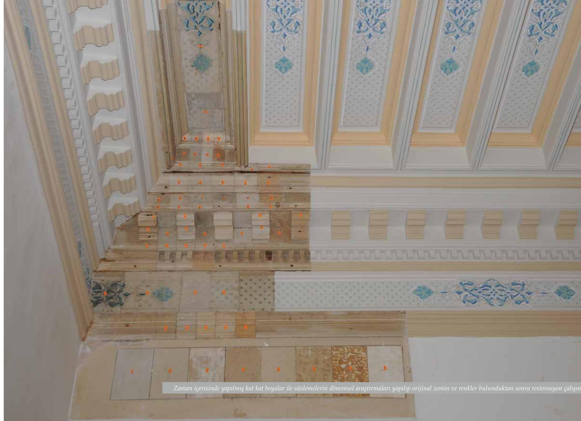
Zaman içerisinde yapılmış kat kat boyalar ile süslemelerin dönemsel araştırmaları yapılip orijinal zemin ve renkler bulunduktan sonra restorasyon çalışm
