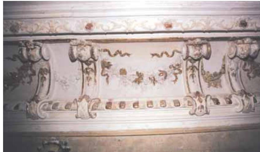
Yangın geçirmiş olan odalarda yapılan kimyasal araştırmalar sonucunda tüm dönemler tespit edilmiş ve karar verilen özgüin uygulama yapılmıştır.
